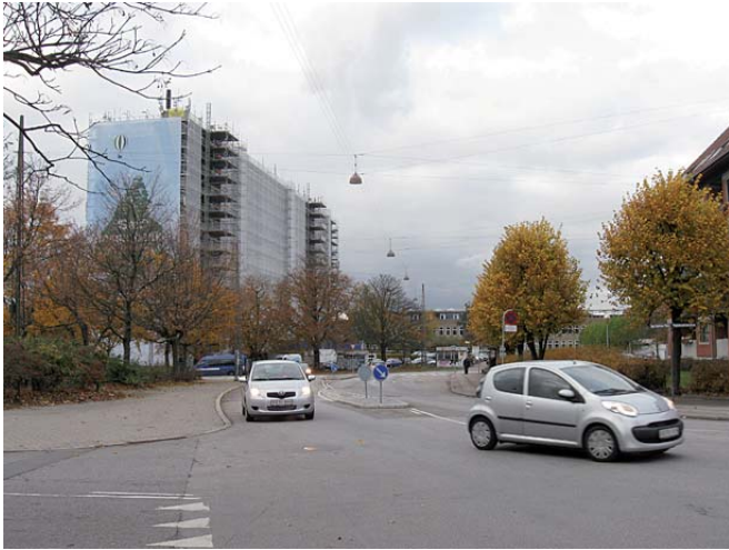
Kollektivhuset ved Hans Knudsens Plads
