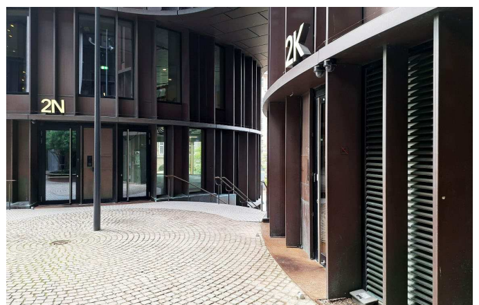
Byhaven mellem bygningerne, hvor der ses tomme lokaler.
