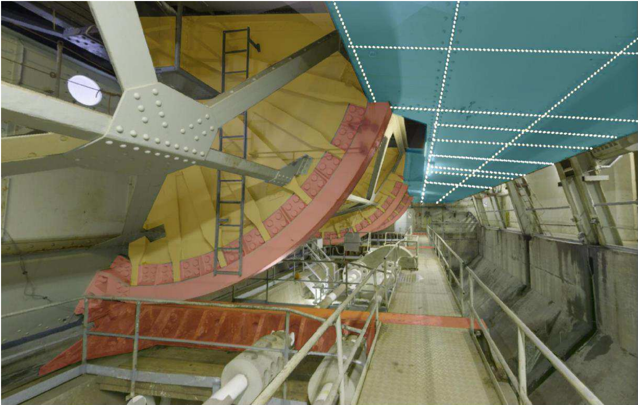
Figur 11: Undersiden af den faste kontravægt markeret med blå. Indre skotter markeret med hvid prikklinje. Rullebaner og rullegænger markeret med rød.
