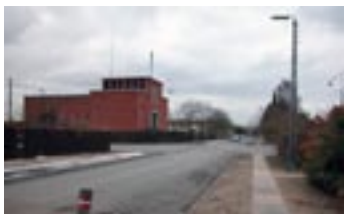
Fuglsang Allé set mod vest med transformerstation i forgrunden, børneinstitution og det eksisterende plejehjem i baggrunden.
