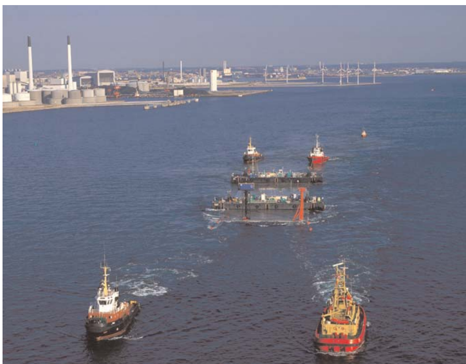
Transport af sænketunnelelement til Øresundsforbindelsen.
