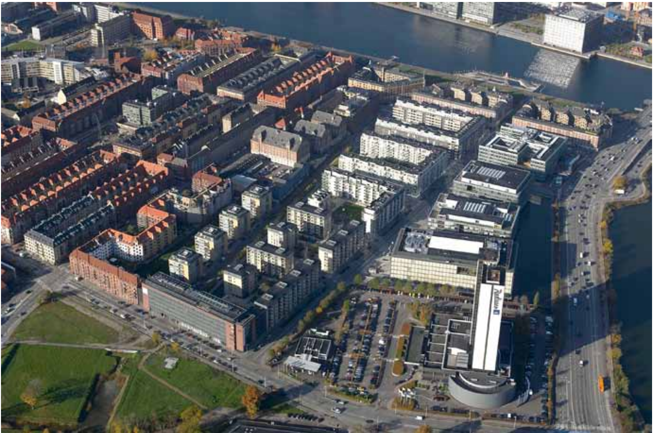
Luftfoto af området med set mod vest (JW Luftfoto okt. 2008). Ny Tøjhusområdet er udbygget fra 2001 til 2009 med 770 boliger og 84.000 m 2 kontorer. Med lokalplantillægget lægges der op til en afrunding af fornyelsen.
