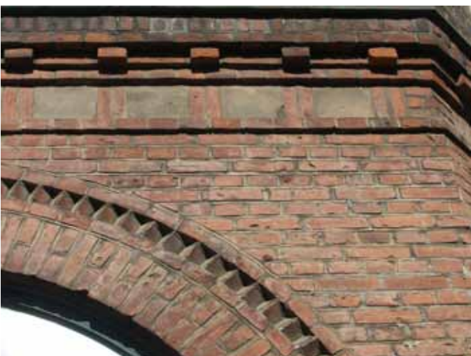
Facadeudsnit mod gade
