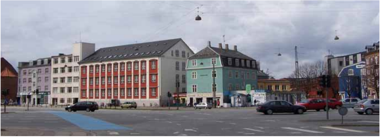
Hjørnet af Jagtvej og Aldersrogade set fra den modsatte side af Vibenshus Runddel. Den nuværende småskalabebyggelse giver hjørnet en lavintensiv og opløst karakter.
