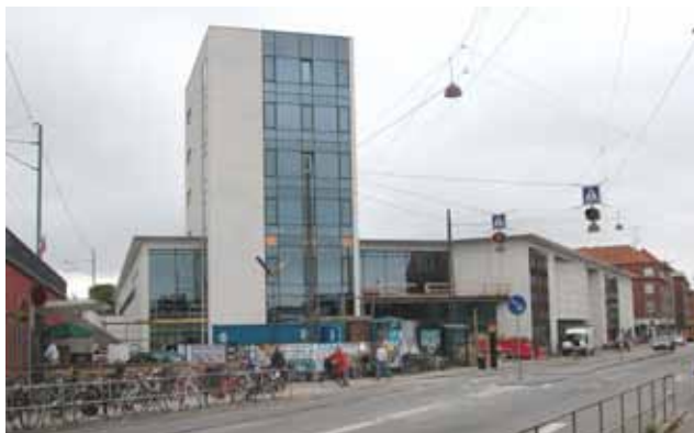
Frode Jakobsens plads med den ombyggede biogafbygning.
