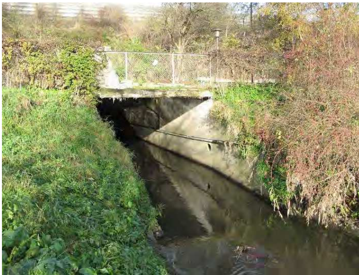
Figur 6-19 Harrestrup Å ved krydsning med jernbanen. Her kan der etableres banketter til faunaen.
