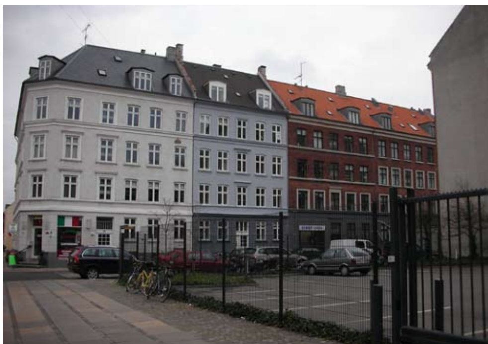
Facader i Fanøgade over for lokalplanområdet.
