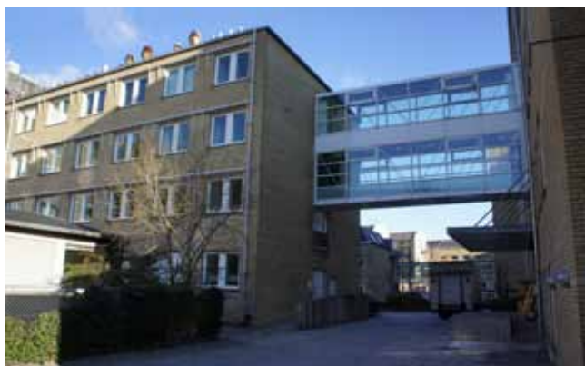
Gangbro mellem Kræftens Bekæmpelses bygninger. Der anes ligeledes en gangbro i baggrunden delvist skjult af en lastbil.
