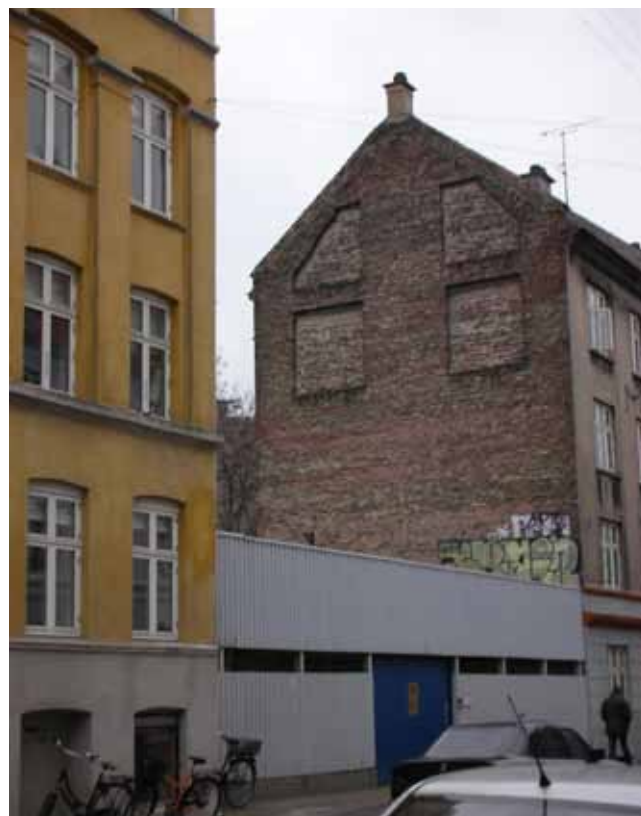
Parkeringshuset i Fanøgade. Her er mulighed for huludfyldning. Til højre ses bygningen, hvor tagboliger kan indrettes.
