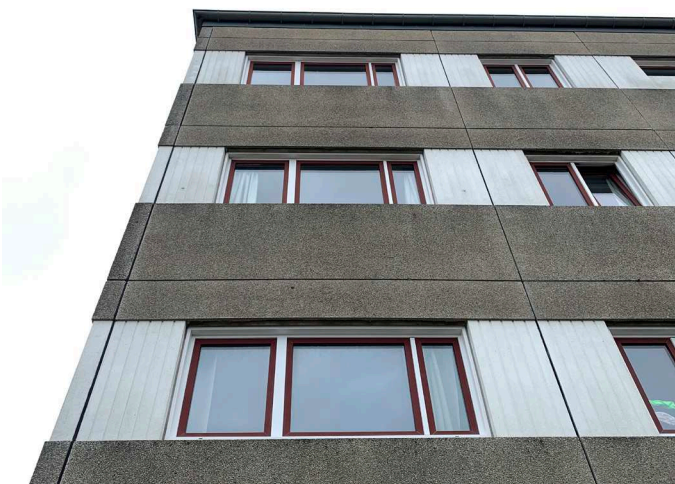
Eksisterende facade og vinduer
