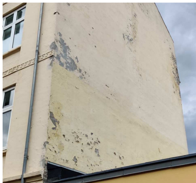
Gavle er nedslidte og uisolerede
