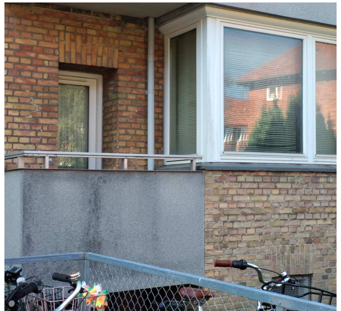
Eksisterende altan- og vinduesparti
