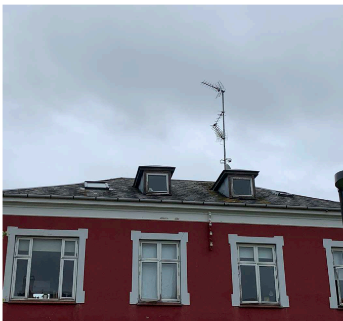
Etablering af ny tagkonstruktion med 2 tagboliger
