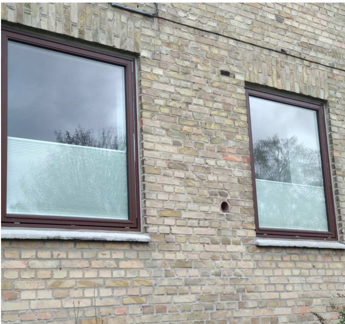
Eksisterende vinduer og facade
