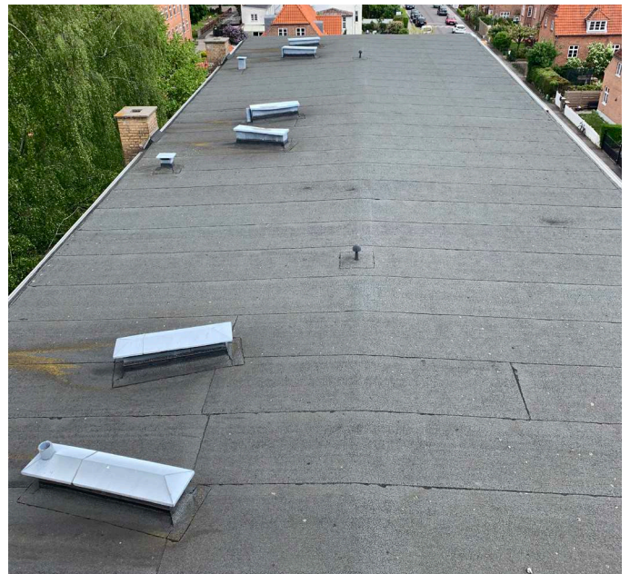
Fladt tag hvor der bliver etableret solceller
