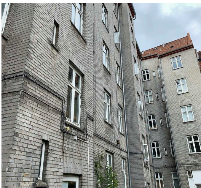
Gårdfacade efterisoleres
