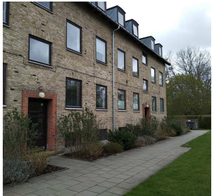
Eksisterende vinduer og opgangsdøre
