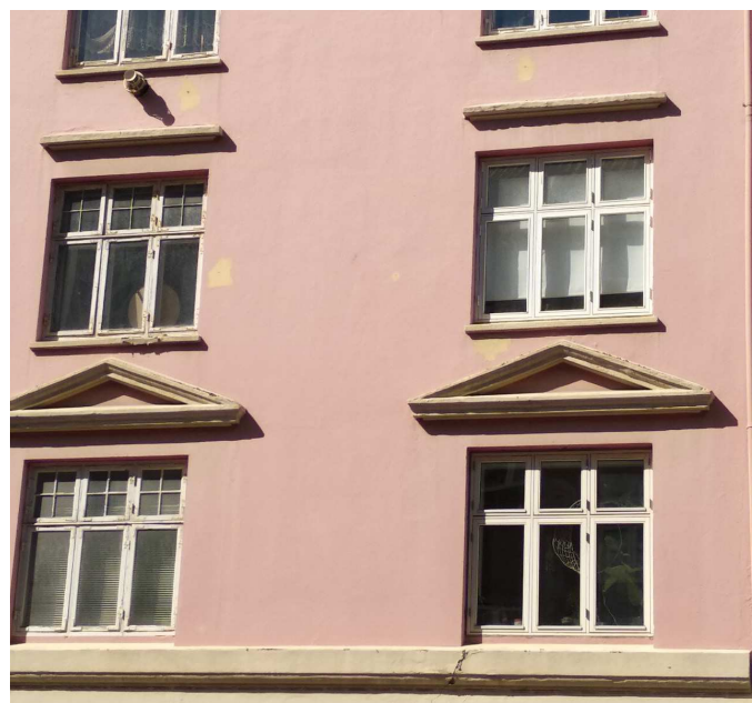
Eksisterende vinduer mod gade
