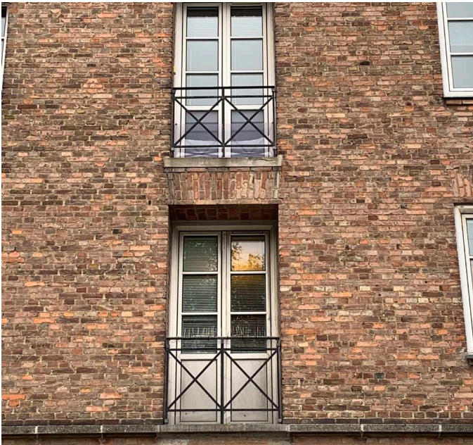
Renovering af altaner og nye støjreducerende døre i træ
