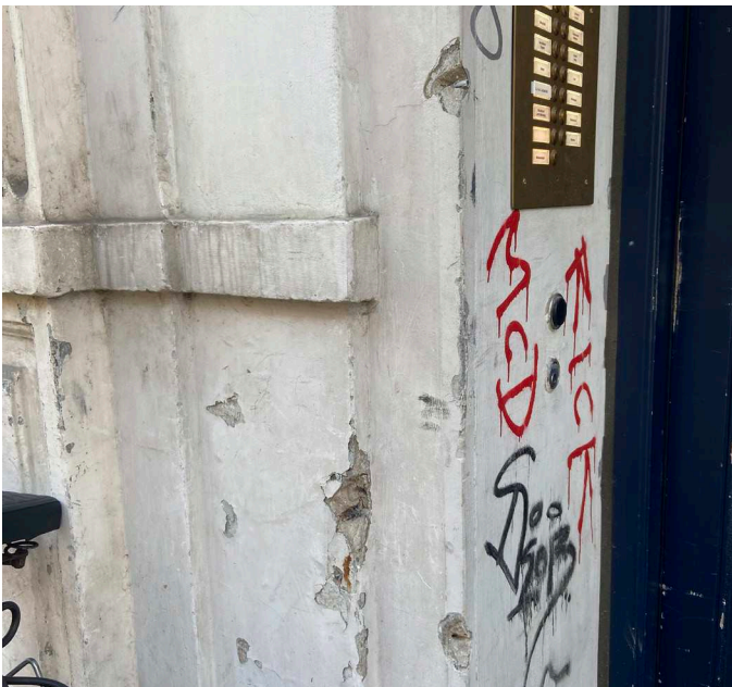
Facader er nedslidte
