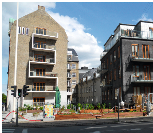
Halmtorvet 29 er ombygget til boliger.
