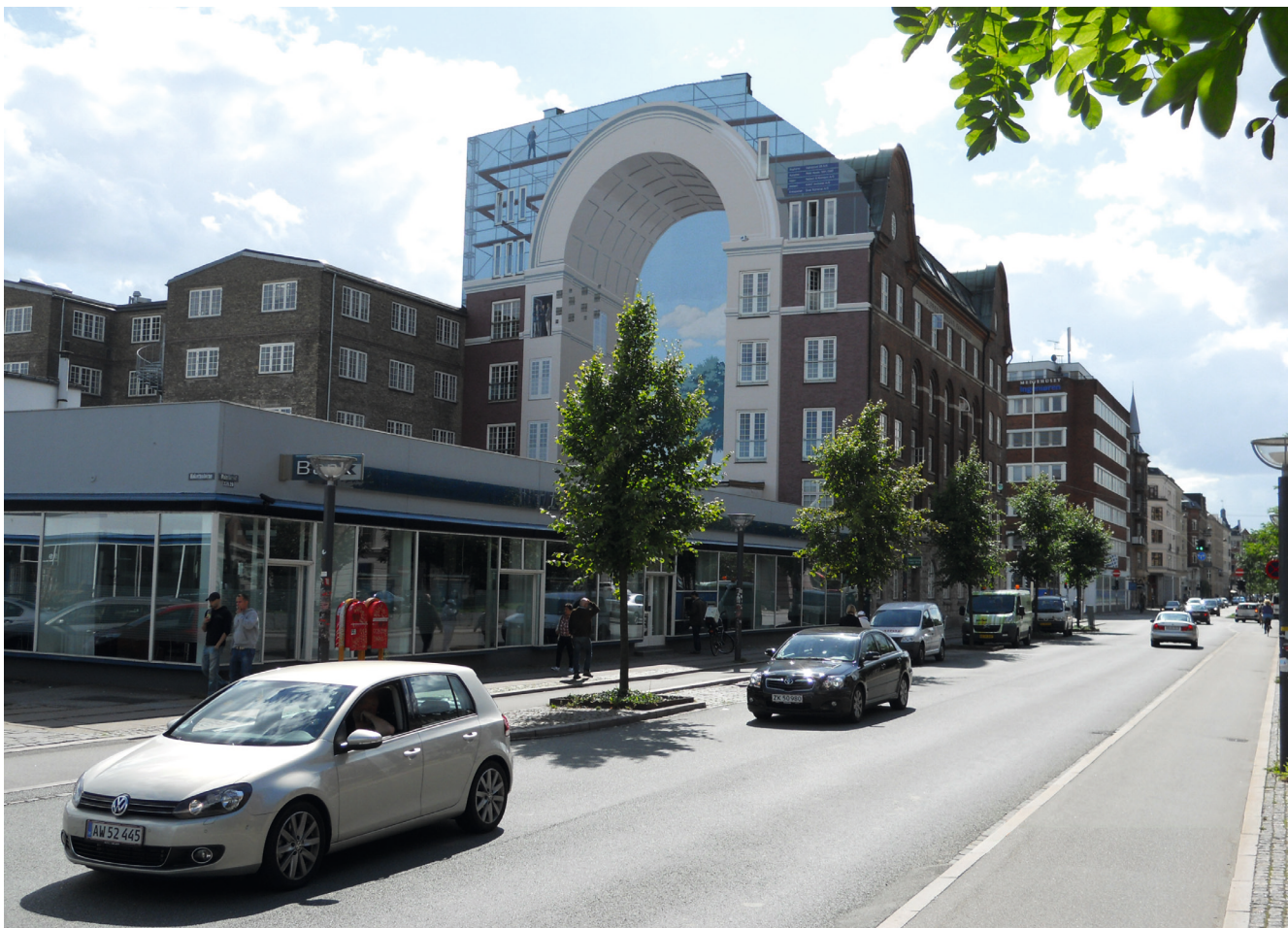
I forgrunden Den Hvide Kødbys randbebyggelse mod Halmtorvet. Bagved den ombyggede "Nomeco-egendom" med gavlmaleri af Peter Abelin
