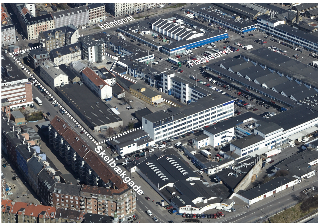
Luftfoto af lokalplanområdet og dets omgivelser set mod nordøst (JW Luftfoto april 2009). Lokalplanområdet er vist indrammet
