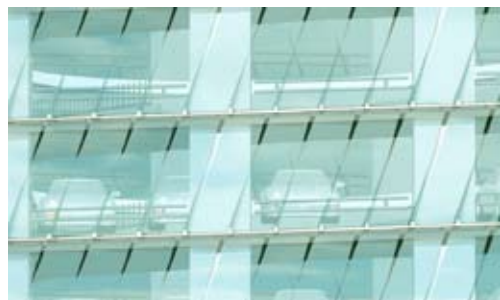
Principper for opbygning af parkeringshusets facade.
