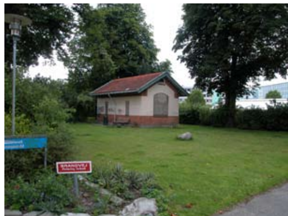
Den bevaringsværdige depotbygning, jvf. bydelsatlas.
