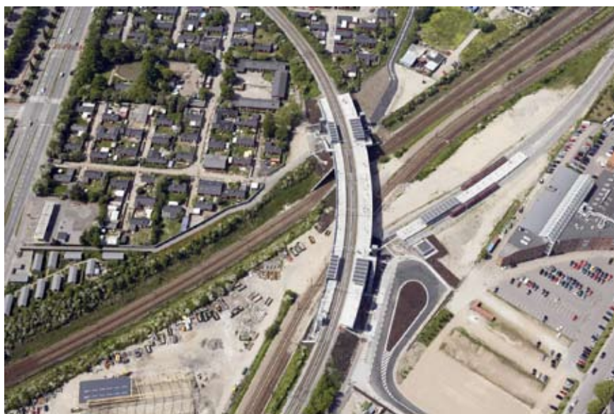
Luftfoto med Ny Ellebjerg Station og de 3 forpladser. Hovedadgangen sker fra den nordlige forplads, der ses til højre.
