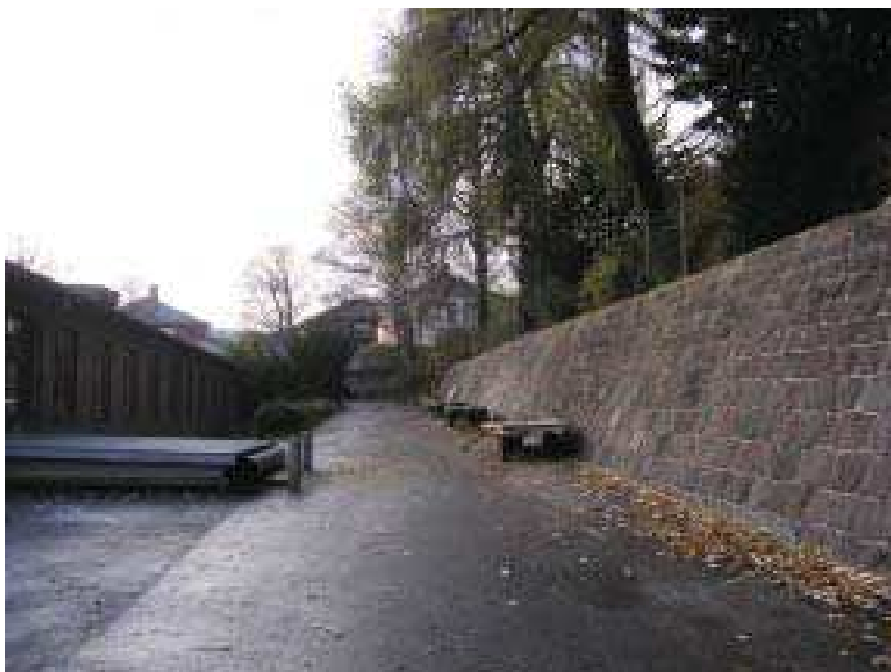
Figur 9-3 Niveauspring op til haven ved Carls villa.
