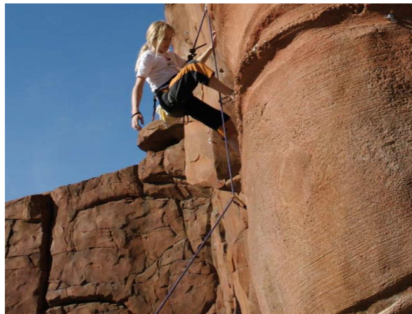
Eksempel på kunstig bjergvæg, opført i beton der er skulptureret til at ligne og føles som rigtig sten. Foto: Abekatten climbing walls
