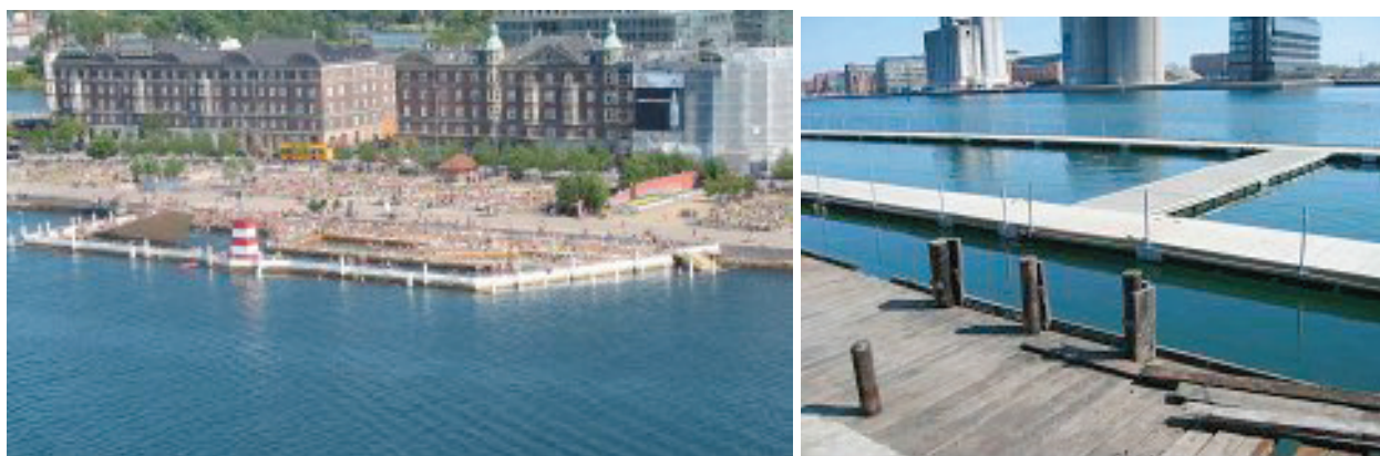
Figur 9-4 Havnebadet ved Islands Brygge. Foto: Københavns Kommune.
