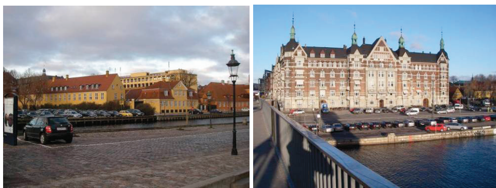
Figur 6-3 Fæstningens Materielgård set mod vest fra Christians Brygge (tv.) og bebyggelsen ved Christians Brygge mellem H. C Andersens Boulevard og Vester Voldgade umiddelbart sydvest for Bryghusgrunden (th.)Foto: COWI.
