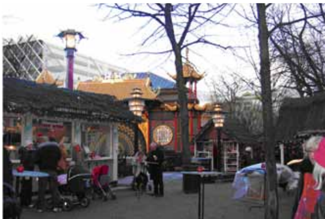
Pantomimeteatret - efter. Den ny facade er i bedre dialog med Tivoli's glasarkitektur.
