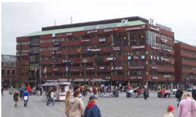
Industriens Hus, opført 1978-80. (Arkitekt Erik Møller).
