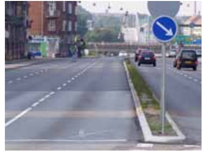
Støjreducerende vejbelægning på Lyngbyvej
