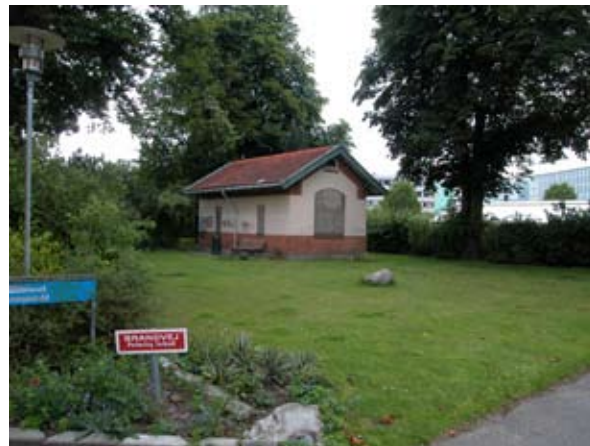
Den bevaringsværdige depotbygning, jvf. bydelsatlas.
