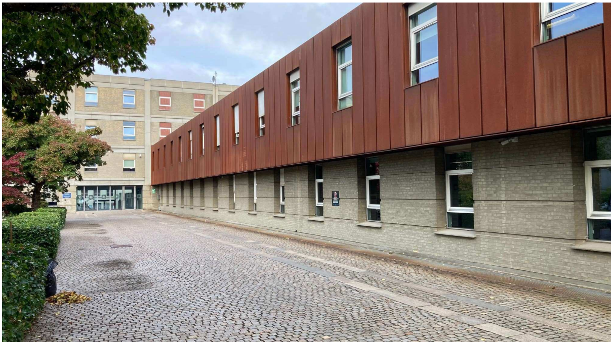
Figur 2 – Facaderne på de to nordlige bygninger er udført i beton og jern. Der er ingen huller eller sprækker med adgang for flagermus.
