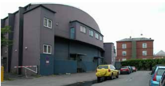
Amager Bio og "Røde Kro" bygningen er begge udpeget som bevaringsværdige bygninger.
