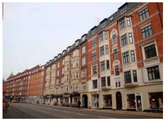
Amagerbrogade 117-127 er opført i årene 1904-1923. Amagerbrogade 123 er et infillbyggeri fra 1993.
