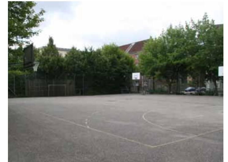
Den eksisterende boldbane ved Prinsesse Charlottes Gade
