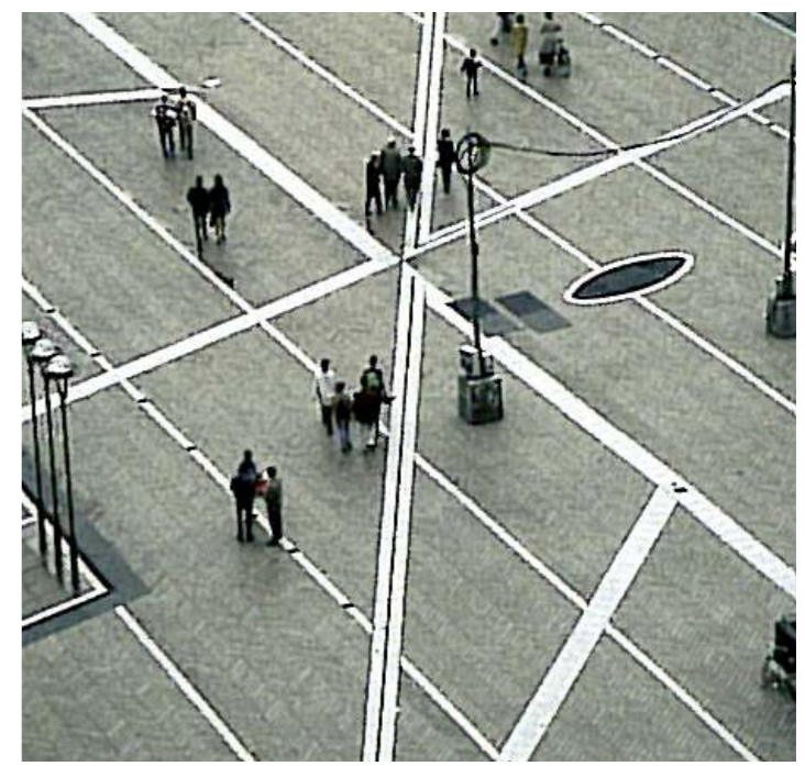
Belægning med forskellige bredder granitbordursten, som markerer ganglinjer i byrummet.
