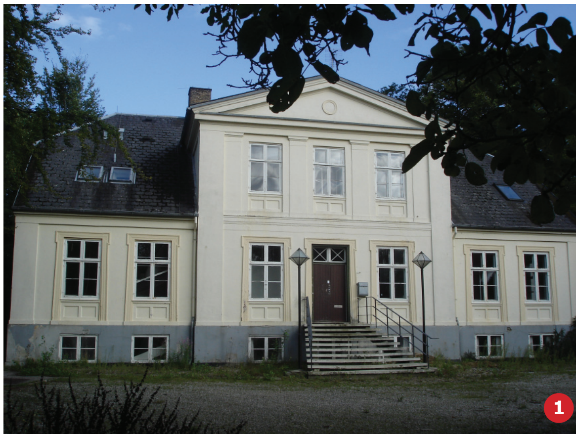
Slotsgade 20 - set fra gårdsplads
