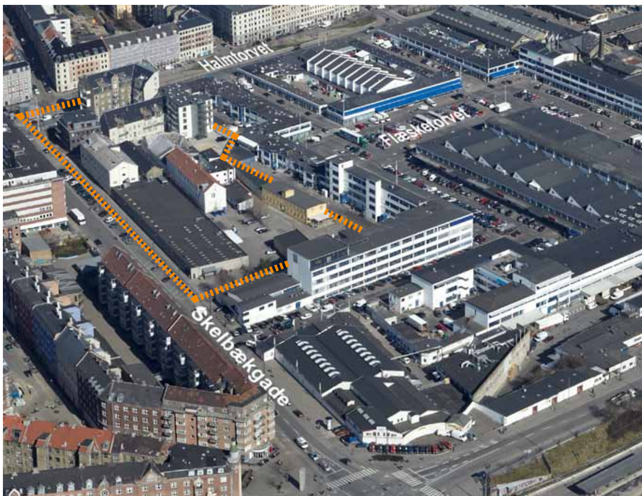
Luftfoto af lokalplanområdet og dets omgivelser set mod nordøst (JW Luftfoto april 2009). Lokalplanområdet er vist indrammet.
