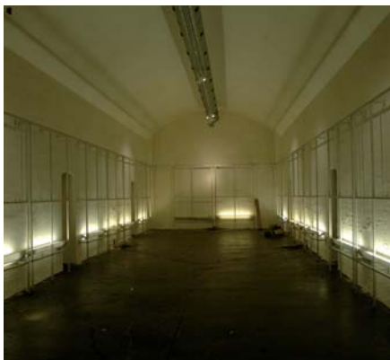
Den eksisterende kælder under pladsen
