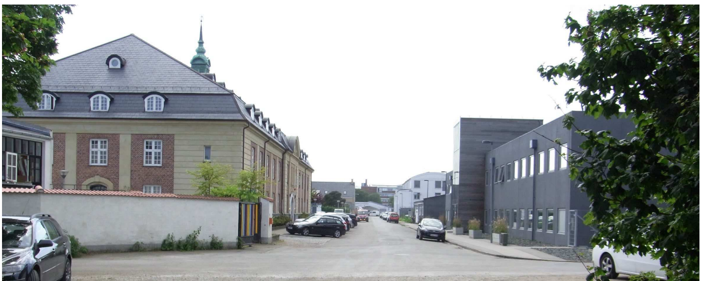
Kig fra den kommende grønne cykelrute 'Amagerruten' mod Lindgreens Allé, der deler området i en større sydlig del og en mindre nordlig del. Enkelte af de tidligere industribygninger er bevaringsværdige, både i kraft af deres arkitektur, og i kraft af deres fortælling om området som et tidligere erhvervsområde. Forrest ses fx Gyldendals tidligere pakhús med spir, og bagest mod nord ses en identitetsskabende hvid fabriksbygning med buet tag.
