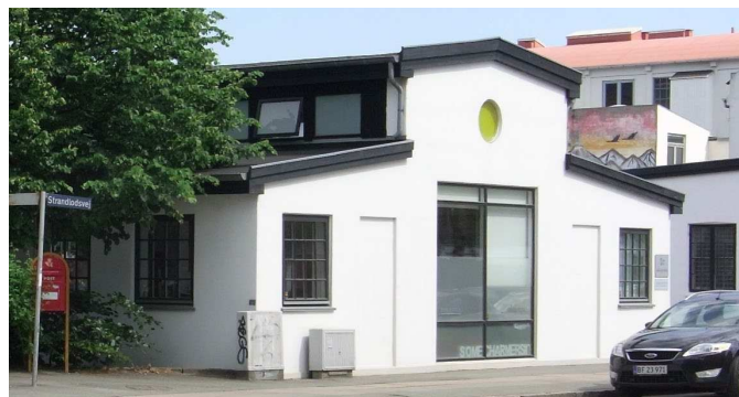
Strandlodsvej 1c Bygninger er opført i 1930 som samleværksted med smedje af Bernh. Petersen, smedemester. Arkitekten var Bertel Hansen. Træerne i forgrunden er også bevaringsværdige.
