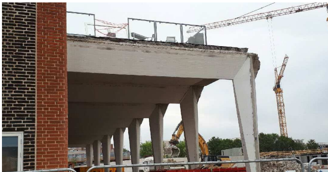
Lindgreens Allé 12, bevaringsværdige bygningskonstruktioner Konstruktionerne stammer fra en tidligere lagerhal, der nu er nedrevet.
