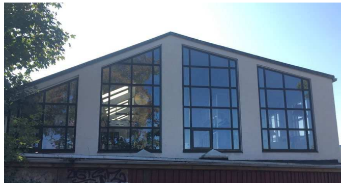
Lindgreens Allé 14 Hovedbygningen udgør en lille fritliggende fabriksbygning fra 1954.
