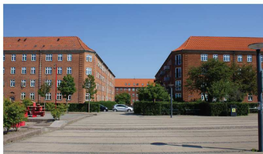
5. Eksisterende belægning på Den Åbne Plads
