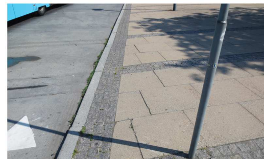
4. Eksisterende belægning ved Den Trafikale Plads
