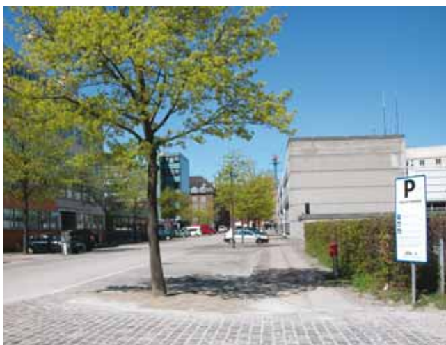
Mitchellsgade set fra Kalvebod Brygge. Byggegrunden til højre bruges midlertidigt til parkering.
