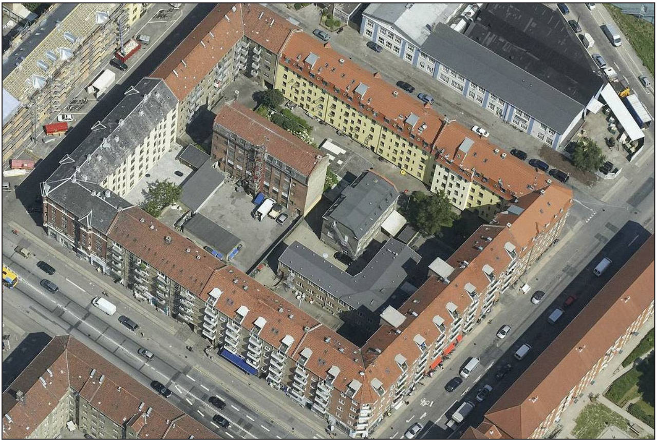
Luftfoto af Glasvej-karréen
