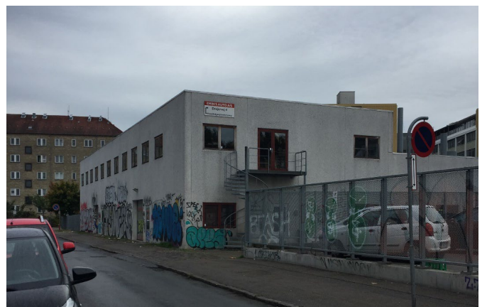
Drejervej 4, set fra Rebslagervej Her opføres nybyggeri.
