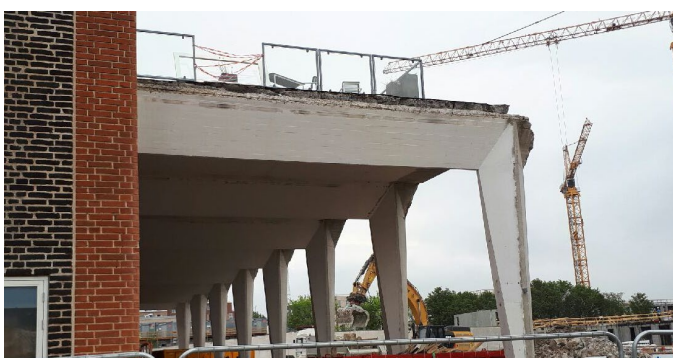
Lindgreens Allé 12, bevaringsværdige bygningskonstruktioner
