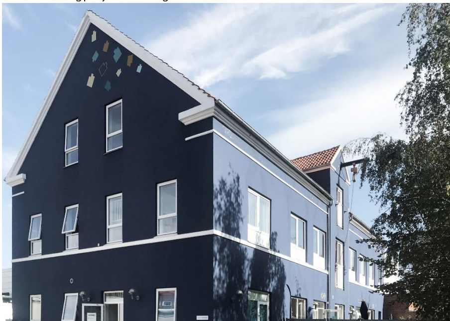
Irlandsvej 5A set mod øst fra Engelsvej/Irlandsvej.
