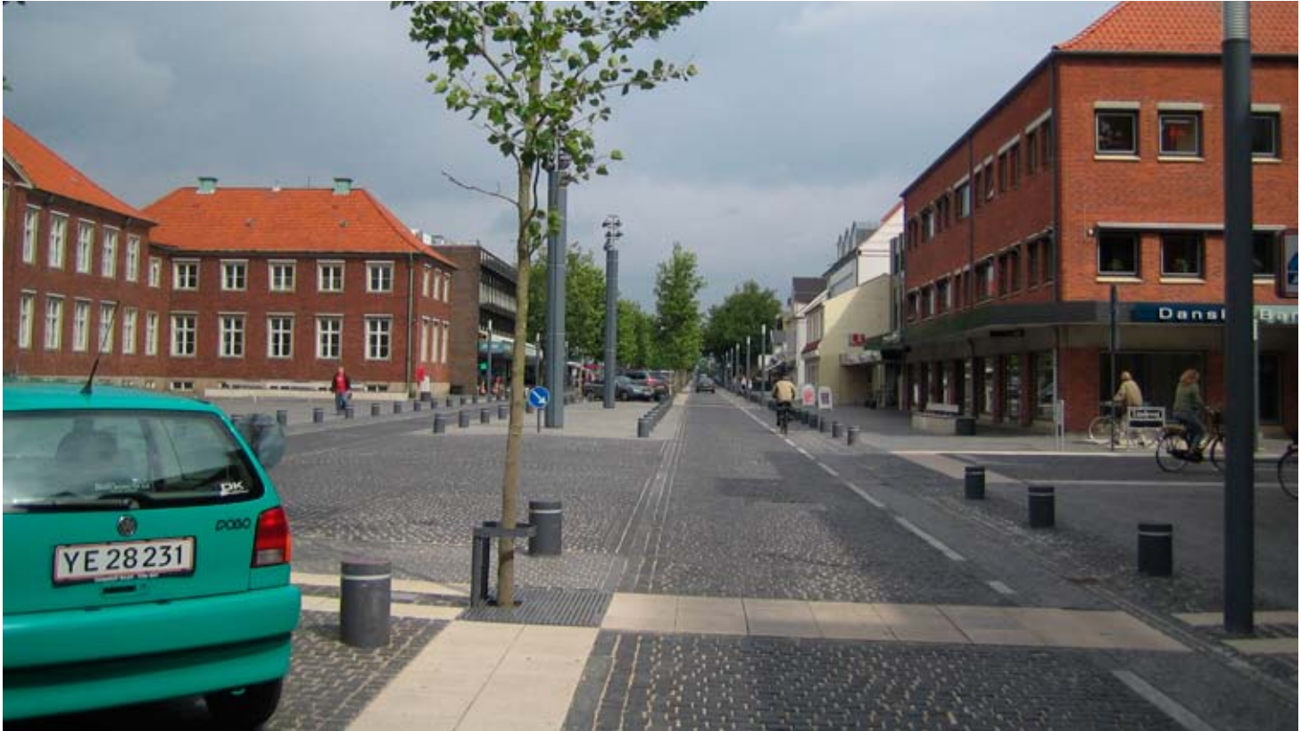
Nørrebrogade Et eksempel på, at der med kendt københavner design er skabt nye kvaliteter i strøggaden.
