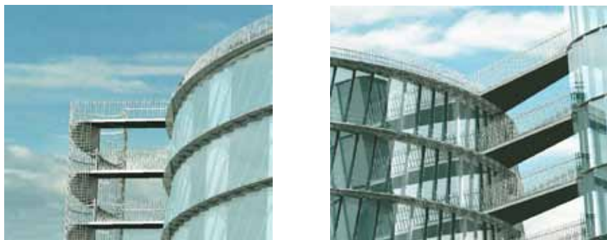
Illustrationerne principiel opbygninger for transparante trappetårne og opbygning af værn.
