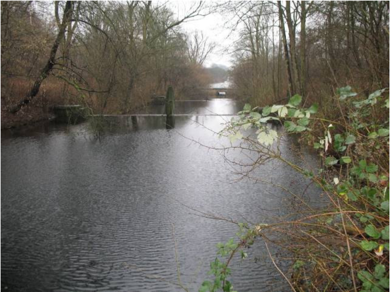
Tilgroning slører oplevelsen af fæstningsanlæggets terrænformer. Her langs fæstningskanalen syd for Frederikssundsvej.
