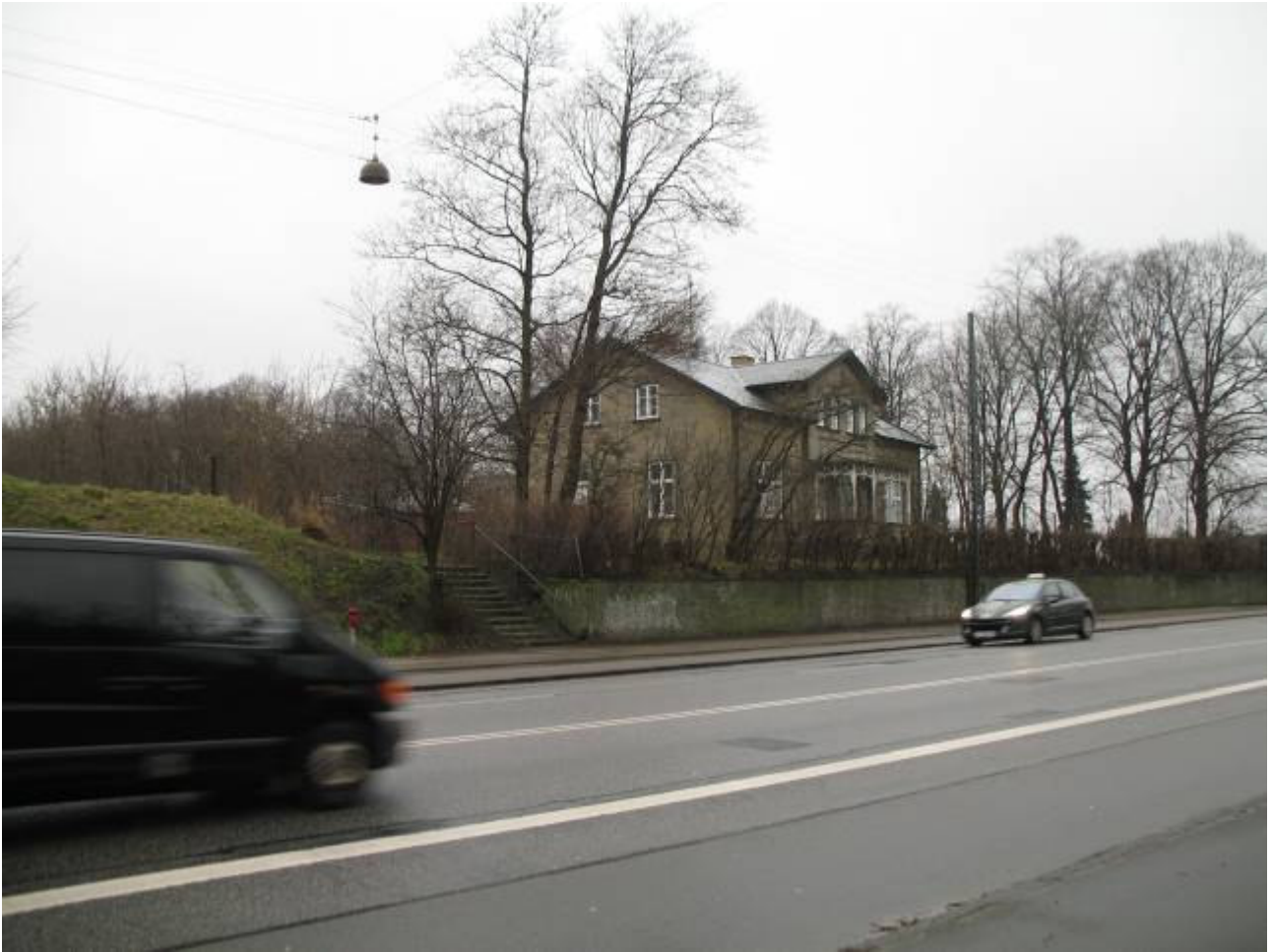
Frederikssundsvej er blot én af de indfaldsveje, som skærer sig gennem Vestvolden.
