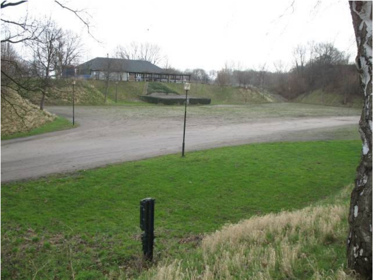
Restaurant og tilhørende faciliteter forstyrrer oplevelsen af det historiske anlæg.
