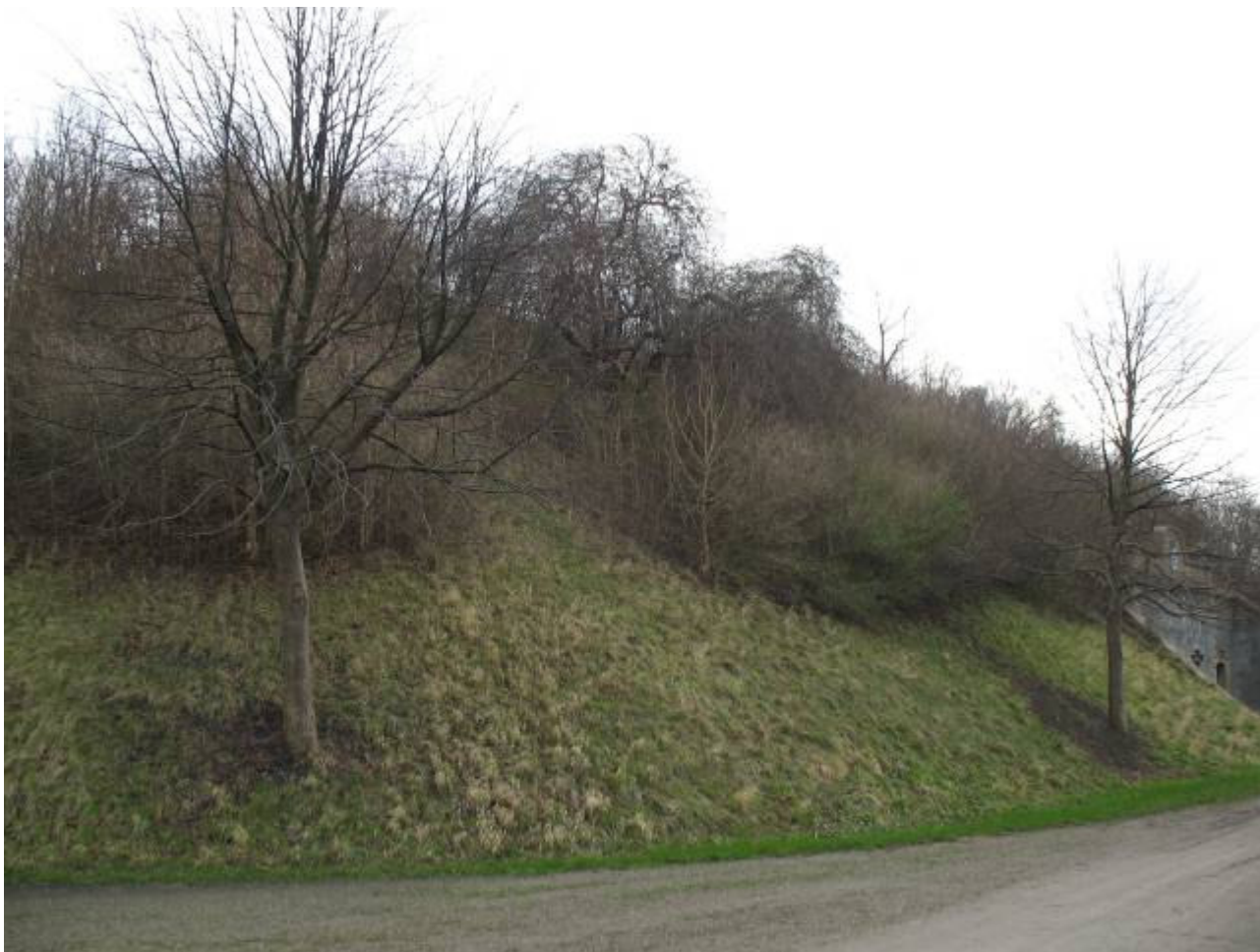
Skråningerne gror til, så anlæggets terrænformer sløres.
