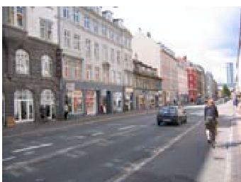
Facade mod Vesterbrogade. Den lave bygning nr. 107C ønskes erstattet af nybyggeri.
