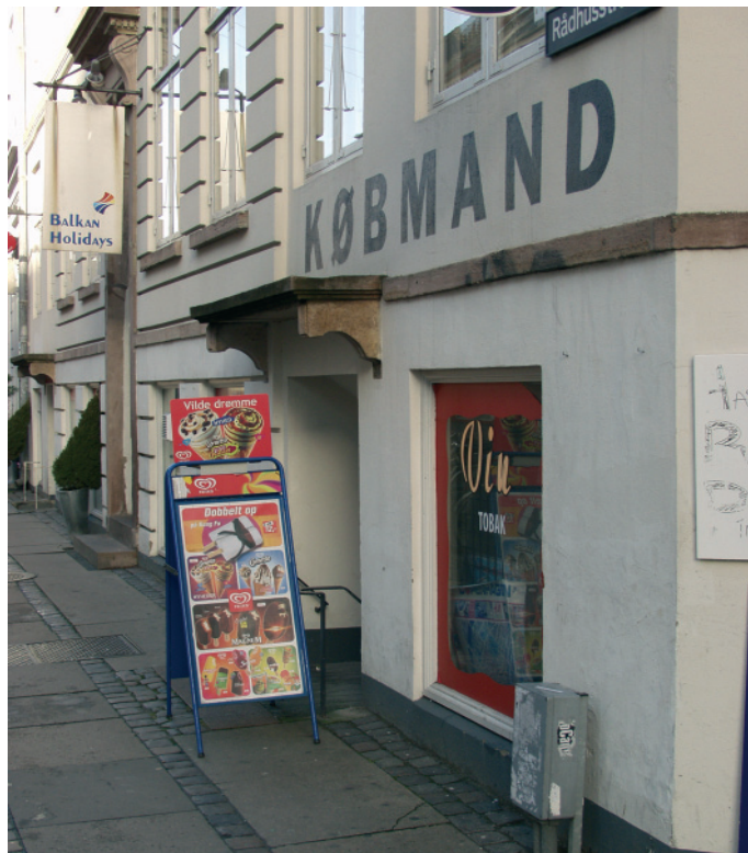
Skilteudstyr placeret på fortovsareal bør generelt begrænses.
