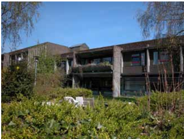
En del af den eksisterende bebyggelse på Sundbyvang som bevarer.
