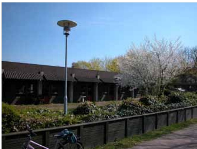
Sundbyvang har små forhaver til hver enkelt bolig der vender ud mod Irlandsvej. Bygningen her sammen med haverne fjernes i forbindelse med nybyggeriet.
