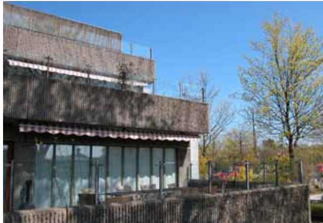
Det eksisterende byggeri er terrasseret mod kolonihavebebyggelsen og villabebyggelsen
