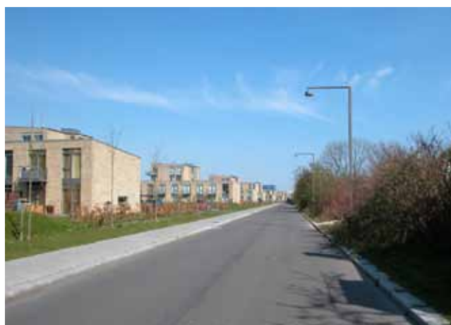
Nordre Digevej set ned mod DR's koncerthus som svagt skimtes i horisonten. Metroen ligger langs med rækkehusbebyggelsen og Nordre Digevej. Lokalplanområdet ligger mellem metrostationerne Sundby og DR byen/Universitetet.
