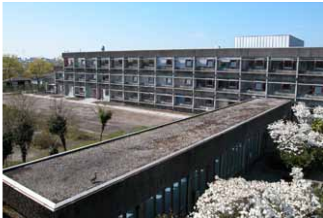
Udsyn over en af de boligblokke som bevares i forbindelse med ombygningsplanerne for Sundbygård. Som det ses er byggeriet 1-3 etager højt
