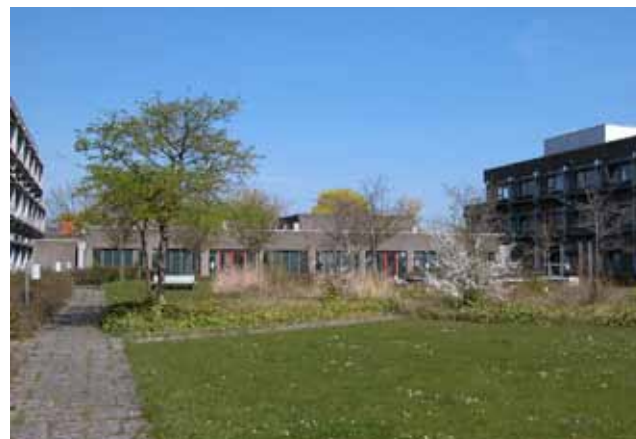
Mellem de eksisterende boligblokke ligger en 1-etages fordelingsgang med fællesfaciliteter til institutionen Sundbygård. Disse fællesfaciliteter skal indrettes i de bygninger der bevares i forbindelse med ombygningen.
