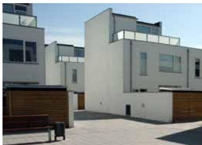
Bebyggelsen er opført i 1-3 etager med forhaver og interne stiferløb. Den variable bygningshøjde giver bl.a. mulighed for tagterrasser der ligger i læ.
