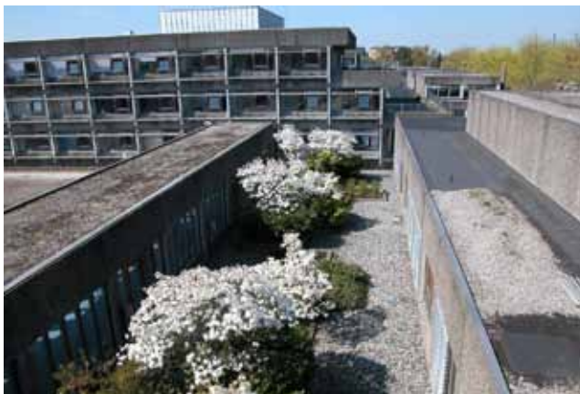
Udsyn over den interne have som bevares i forbindelse med ombygningsplanerne for Sundbygård
