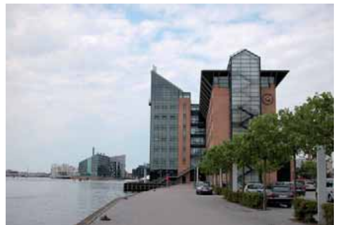
Kalvebod Brygge (eksisterende forhold)
