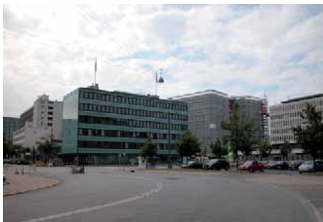
Falckhuset set fra Polititorvet (eksisterende forhold).
