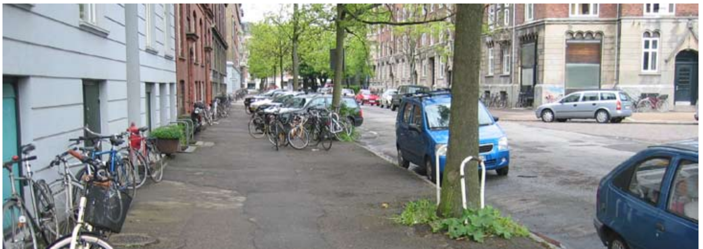
Belæggningerne i Hjort Lorentzensgade er slidte, og mange gentagne reparationer præger overfladen. Cykler er der mange af, og de parkeres gerne i nærheden af indgangene.
