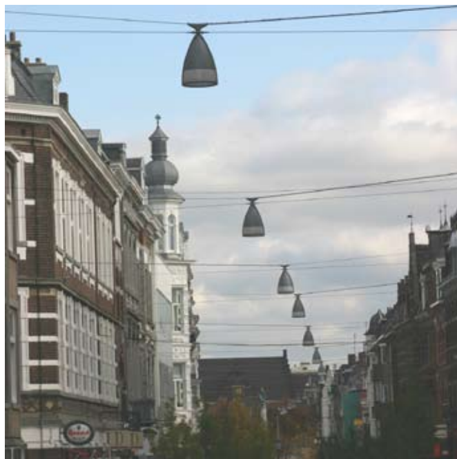
Wirehængte armaturer til gadebelysning udskiftes og antallet forøges
