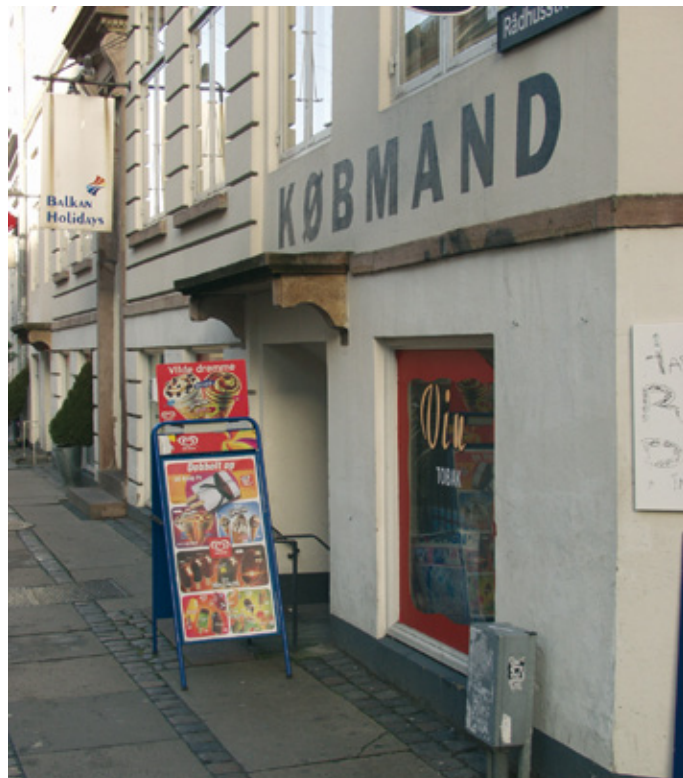
Skilteudstyr placeret på fortovsareal bør generelt begrænses.
