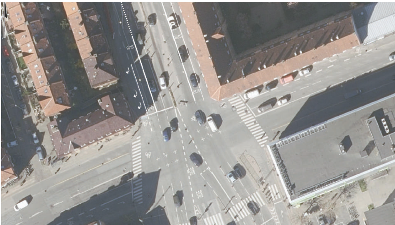
Figur 21 Midterlagt til sidelagt tracé ved Haraldsgade.
