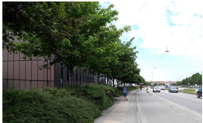
Bebyggelses- og beplantningskarakter langs Sjællandsbroen.
